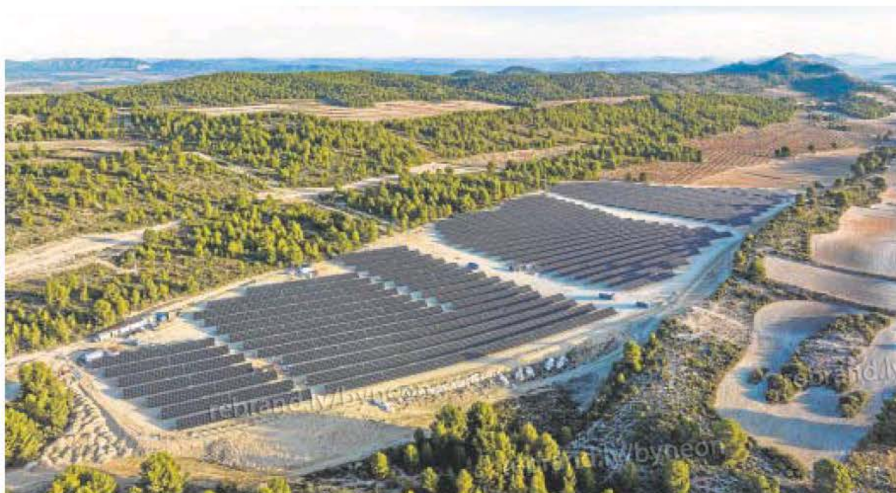
Una de las instalaciones de generación de energía fotovoltaica desplegada por la compañía
