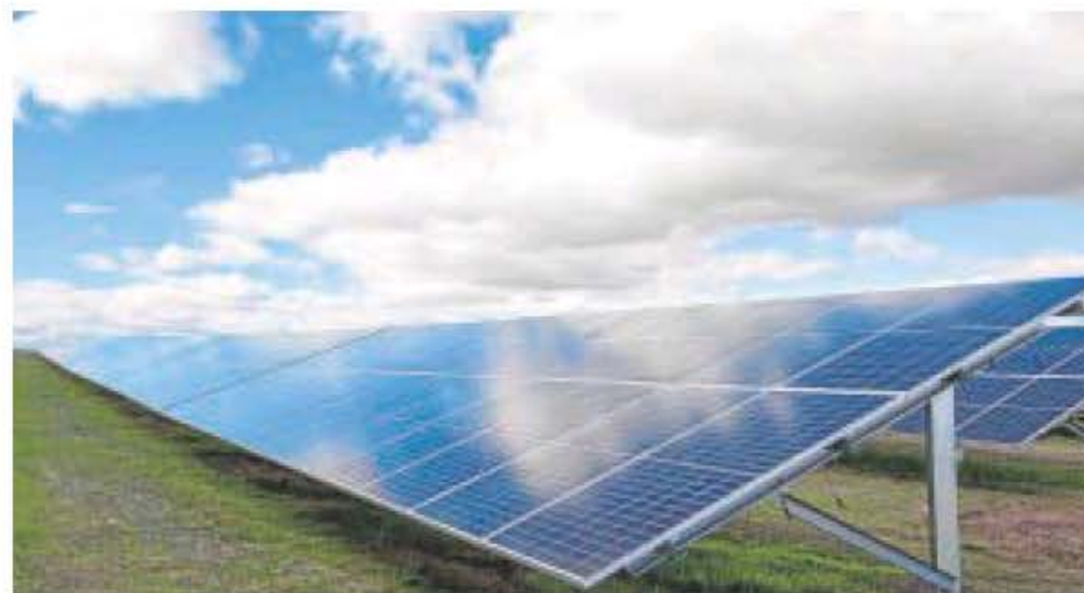
La compañía ha realizado instalaciones en toda España // ISE ENERGÍA
