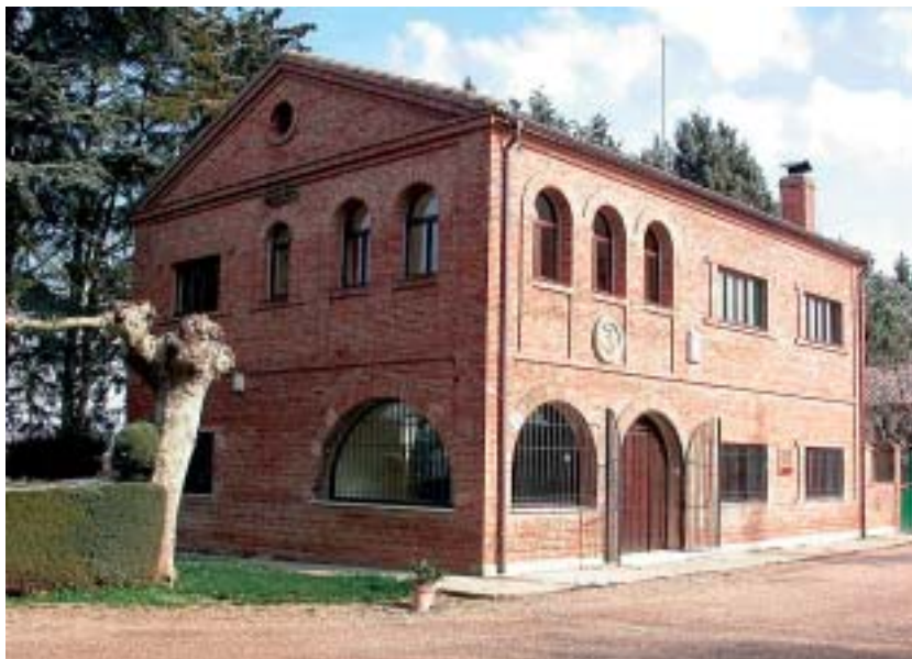
Edificio del centro de Sanidad Forestal de Castilla y León
