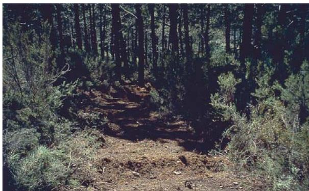
Al construirse el caballón, o zanja, se debe tener presente que la sección perpendicular es una **L**, no una **V**.
