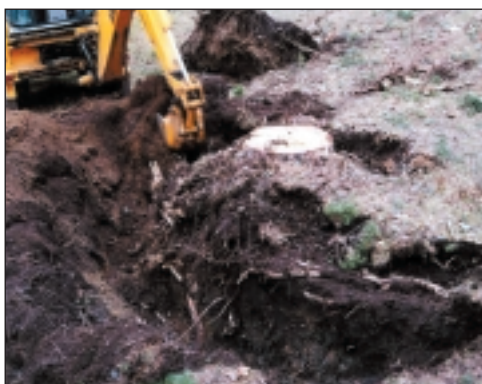
Apertura del hoyo alrededor del tocón.
