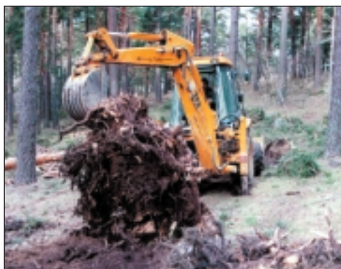
Extracción del tocón y raíces gruesas.
