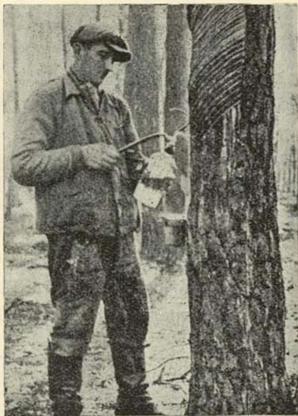
Fig. 10. — Resinero alemán pulverizando con ácido clorhídrico.
