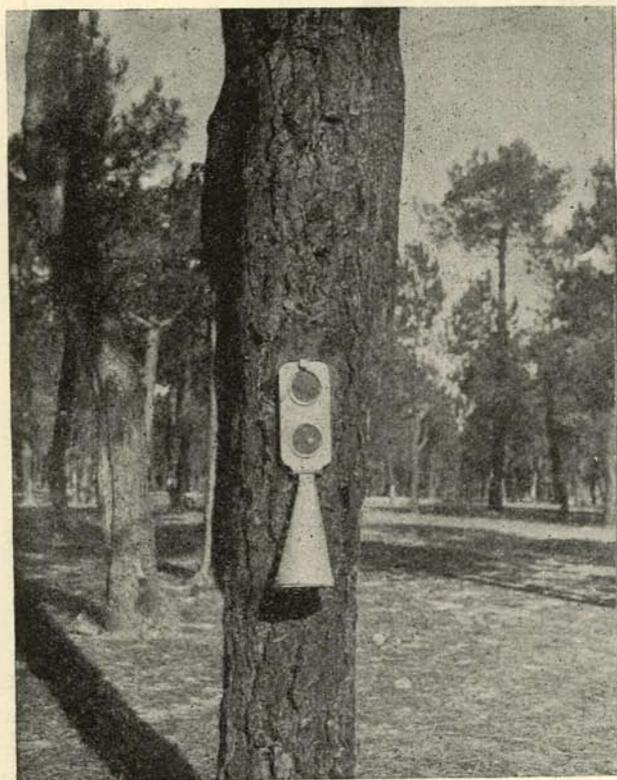
Fig. 5.<sup>a</sup> — Caja protectora y botella de recogida de miera en el sistema de resinación Bellini.
