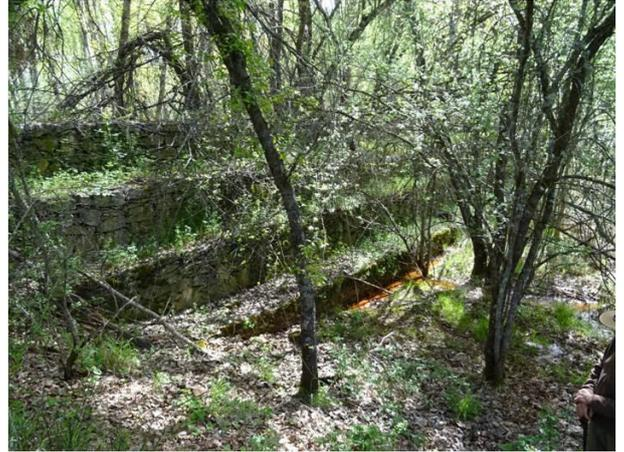
Foto 9 - Evacuación de agua al pie del dique en modo laminar, ya que la estructura de mampostería gavionada es permeable. Se comprueba la altura útil del dique. Es una rambla, no un río. (29/04/2025).
