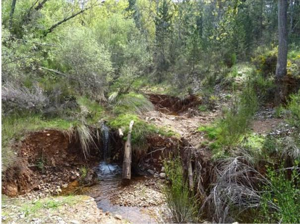
Foto 8 - El cauce aguas abajo del dique ha reducido su divagación, ha favorecido la colonización vegetal y manifiesta una erosión remontante al recibir aguas sin caudal sólido gracias al dique. (29/04/2025).
