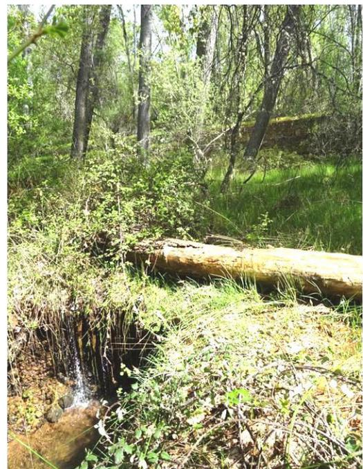
Foto 11 - Panorámica en la que se comprueba que la distancia entre la profundización del cauce y la base del dique es de 20 m. Si esta profundización llega a los cimientos del dique se puede producir su sifonamiento y producir daños a su estabilidad. (29/04/2025).
