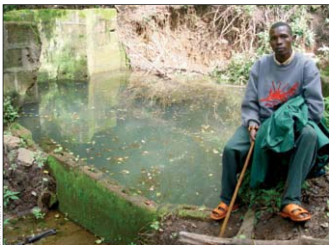
El agua de un embalse construido hace unos 30 años se traslada a través de tuberías hasta los estanques de contención que abastecen a las comunidades locales
